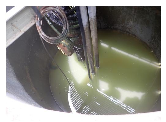
Photo 18 : Effluent wet well.
